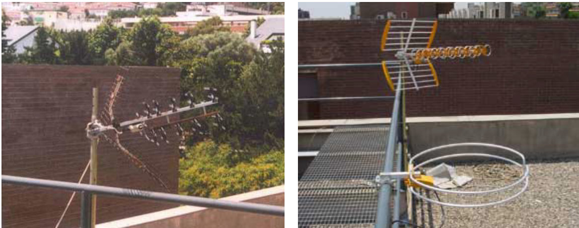
Figura 11. Antenas de televisión y radio del demostrador de ICT. Antena inicial (izquierda) y antenas nuevas (derecha)
