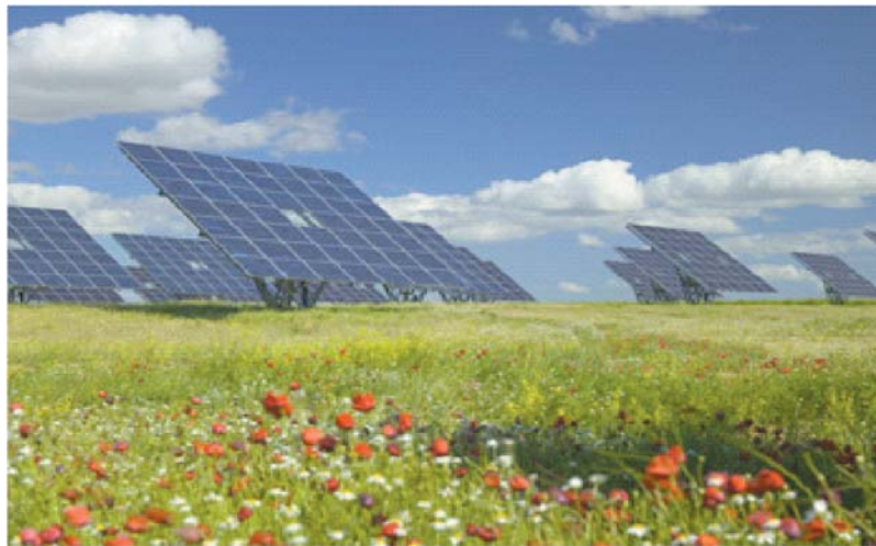
Figura 20. Instalación sobre suelo con sistemas de seguimiento
