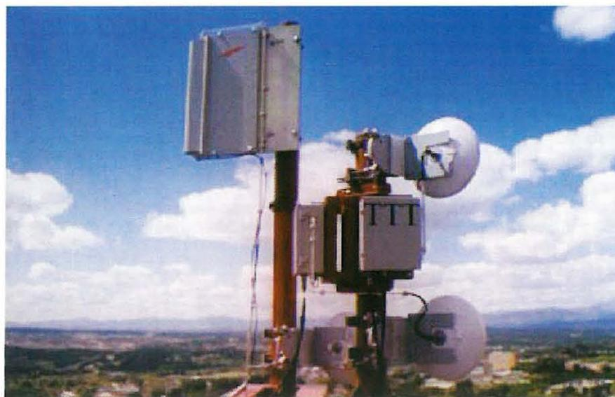
Fig 2: Instalación de estación base de LMDS
