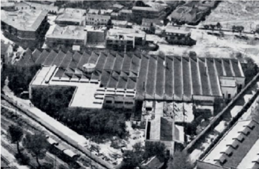
Sede de Ericsson en la localidad de Getafe. Fuente: Ericsson.
